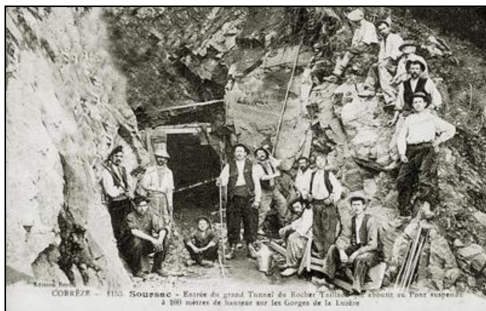
De fiers ouvriers à la sortie du tunnel, du temps de sa construction
