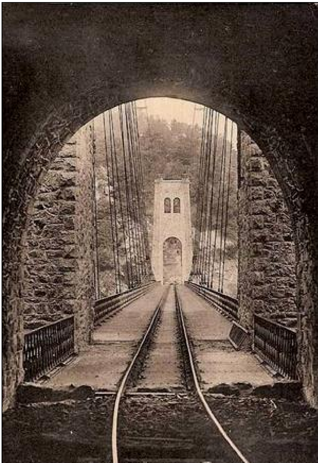
Le viaduc pris depuis l'entrée du tunnel, du temps du petit train
