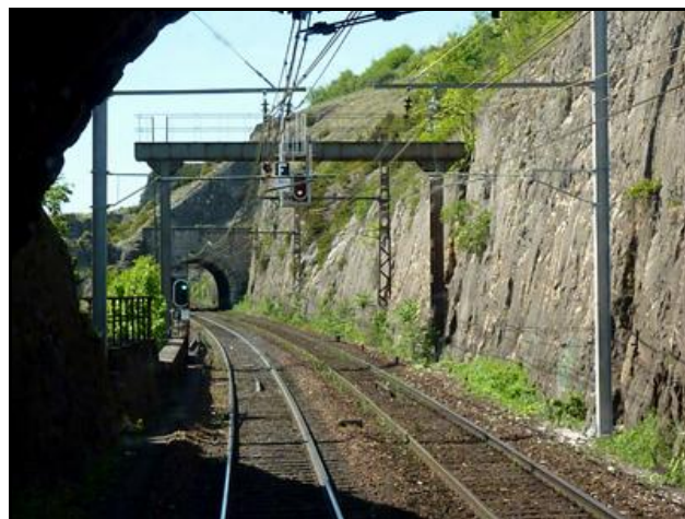
La sortie du tunnel vue depuis l'entrée de celui de Dijon 3
