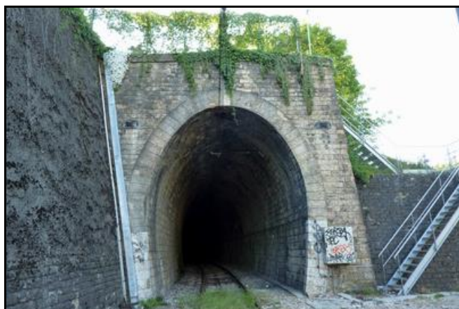
La belle entrée du tunnel
