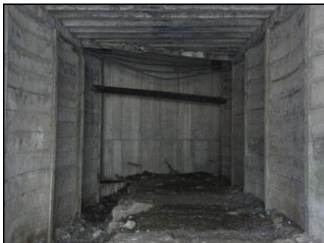
La curieuse galerie construite avec des éléments en béton armé préfabriqués
