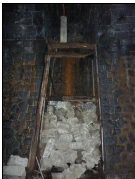
Ci-contre, la cheminée d'aération décentrée
