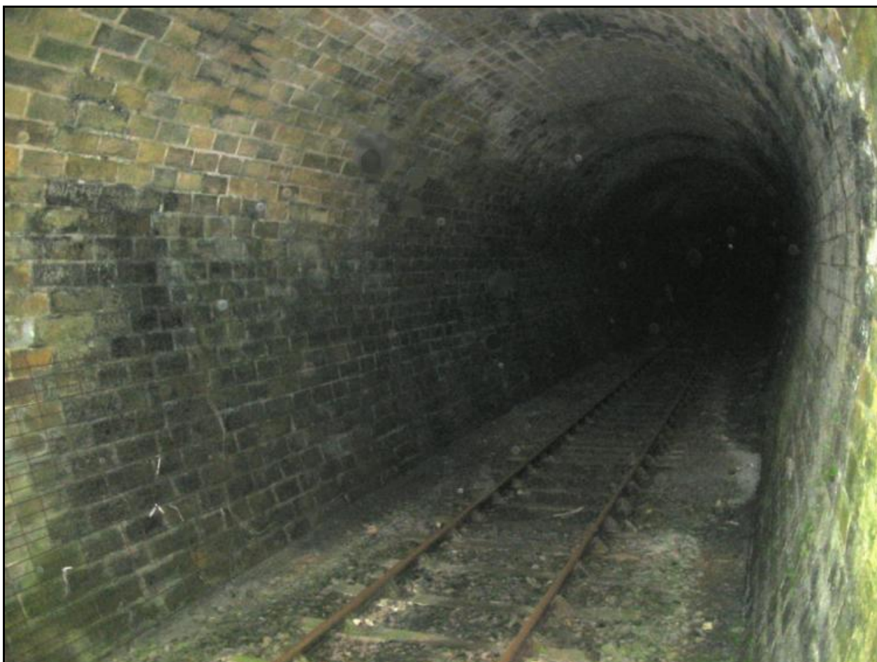
La galerie conservée dans son état initial
