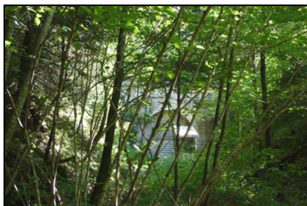
Ci-contre, l'entrée du tunnel murée et perdue dans la végétation
