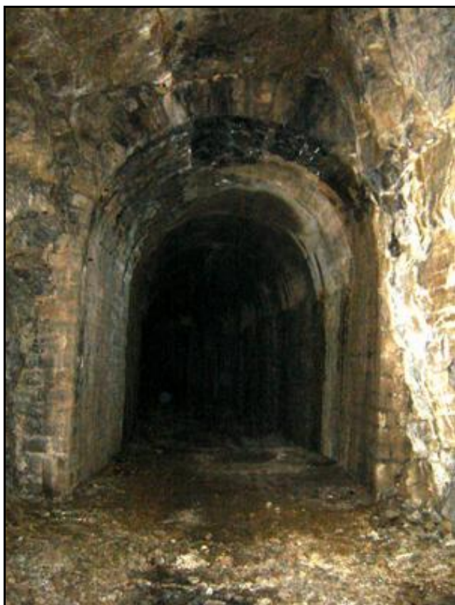
La fin maçonnée de la galerie avec sa voûte en béton armé suite aux dégâts de guerre
