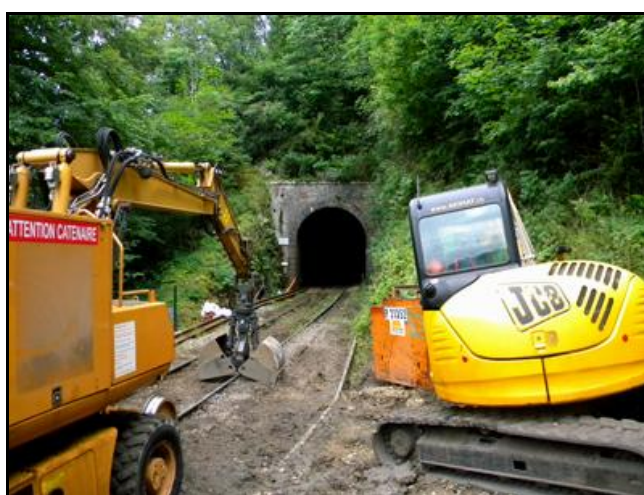
Ci-dessus et ci-dessous, trois photos de l'entrée du tunnel pendant une campagne de renouvellement de la voie
