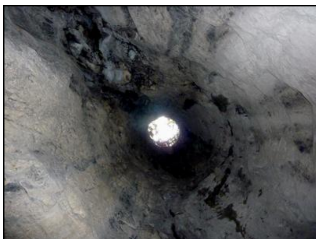
La cheminée taillée directement dans la roche brute, vue de dessous
