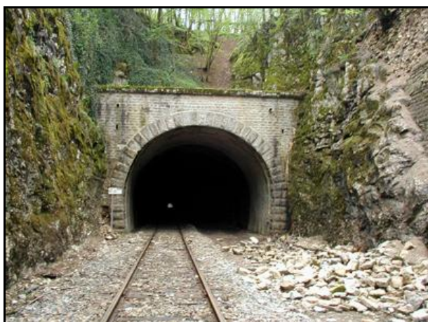
Ci-dessus et ci-dessous, l'entrée et la sortie du tunnel dans leur état primitif, avant travaux de réfection
