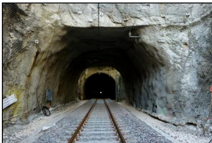
A l'arrière-plan, la sortie du tunnel de Saint Claude 2
