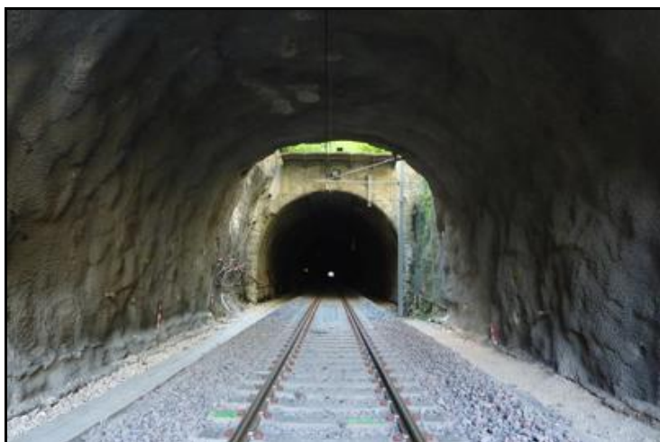
L'entrée vue de l'intérieur avec la sortie du tunnel de Saint Claude 2
