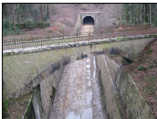
La sortie du tunnel suivie d'une longue tranchée avec trois ponts (photo prise du deuxième pont)
