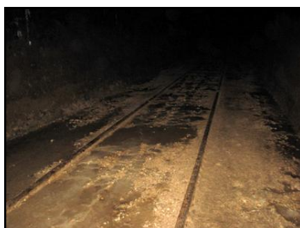
Les rails sont encore visibles dans la partie proche de l'éboulement de l'entrée
