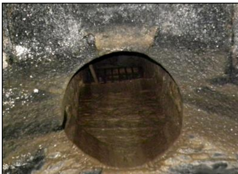
Débouché d'un puits d'aération dans la voûte du tunnel
