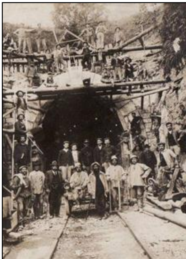
Le tunnel en construction
