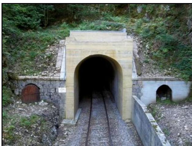
Les orifices du tunnel avec leurs fourneaux de minage latéraux
