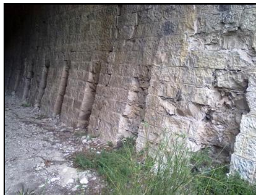
Ci-dessous, des entailles ont été creusées dans la base des pénétrants pour tenter de placer des cintres métalliques de soutien, mais cette formule n'offrait pas une sécurité suffisante
