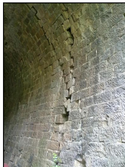
Ci-dessous, des entailles ont été creusées dans la base des pénétrants pour tenter de placer des cintres métalliques de soutien, mais cette formule n'offrait pas une sécurité suffisante
