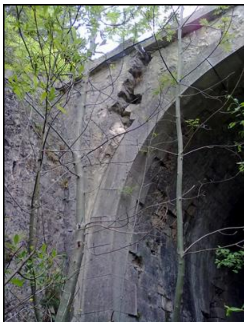
Ci-dessus et ci-dessous, état de dislocation des deux frontons d'entrée et sortie
