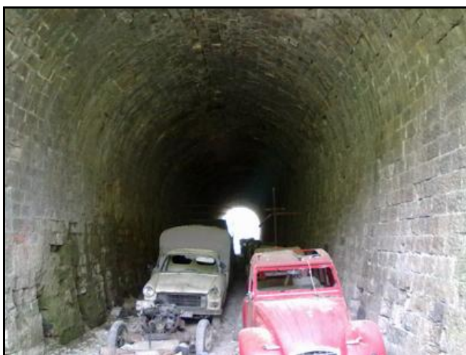
Ci-dessus et ci-dessous, divers aspects de la galerie en état de rupture imminente
