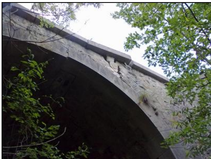
Ci-dessus et ci-dessous, état de dislocation des deux frontons d'entrée et sortie
