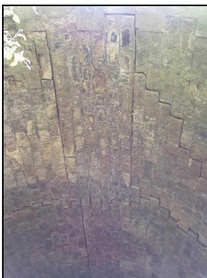
Ci-dessous, des entailles ont été creusées dans la base des pénétrants pour tenter de placer des cintres métalliques de soutien, mais cette formule n'offrait pas une sécurité suffisante
