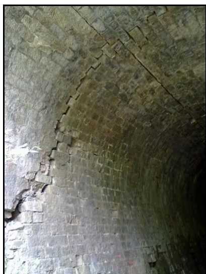
Ci-dessus et ci-dessous, divers aspects de la galerie en état de rupture imminente
