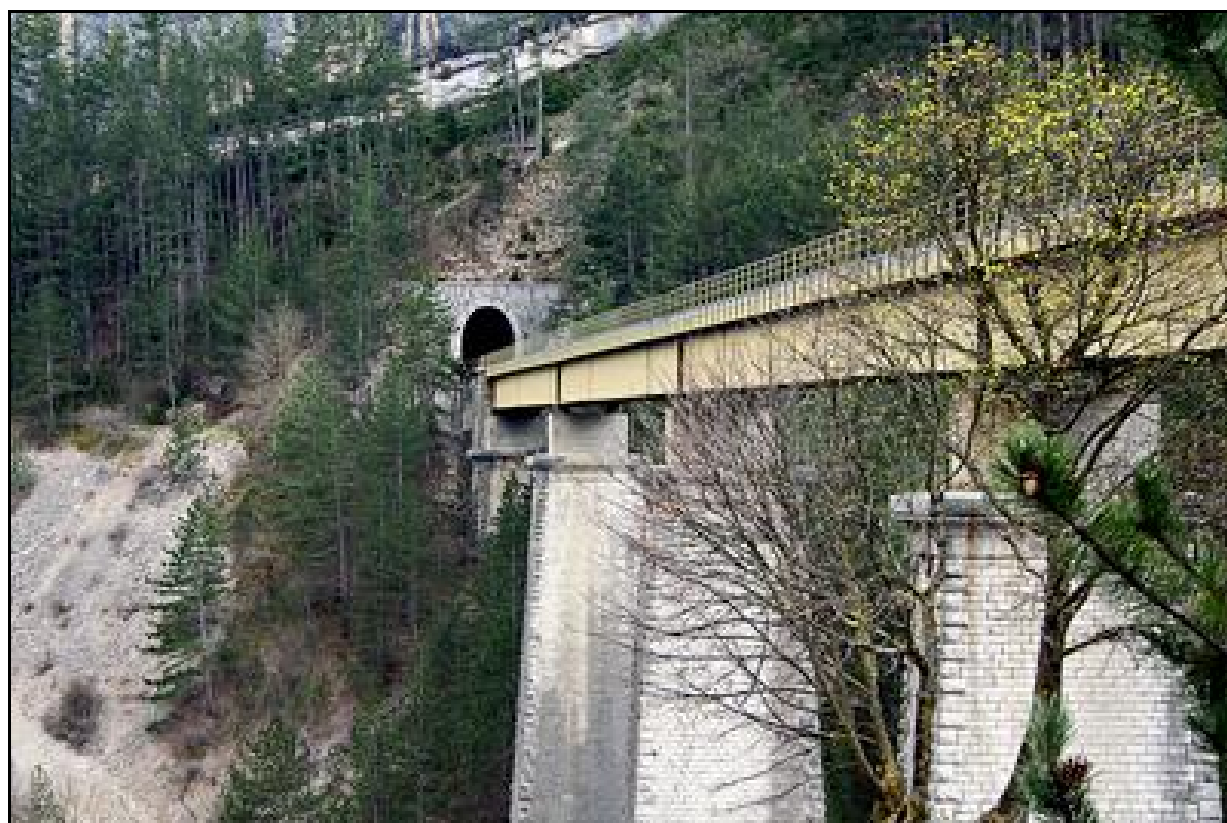
L'entrée du tunnel après le nouveau viaduc du Claps
