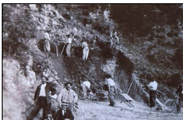
Début de la fouille d'entrée du tunnel Noter que tous le travail est entièrement manuel, pioches, pelles et brouettes
