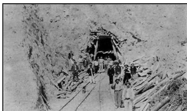
Ces deux photos montrent un stade plus avancé de la galerie de reconnaissance dont le radier a été abaissé On notera aussi le fait que les brouettes sont remplacées par un wagonnet sur rails
