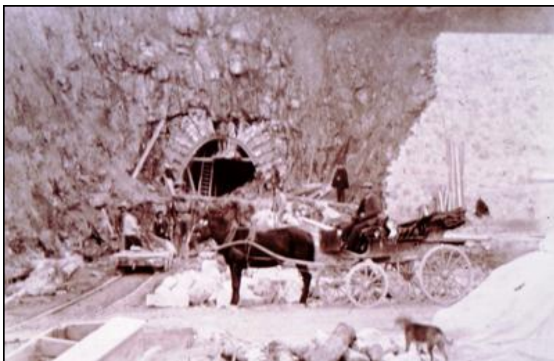
Puis les piédroits de la galerie de reconnaissance ont été abattus pour créer l'arrondi de la voûte Aussitôt mise en sécurité par construction de sa maçonnerie
