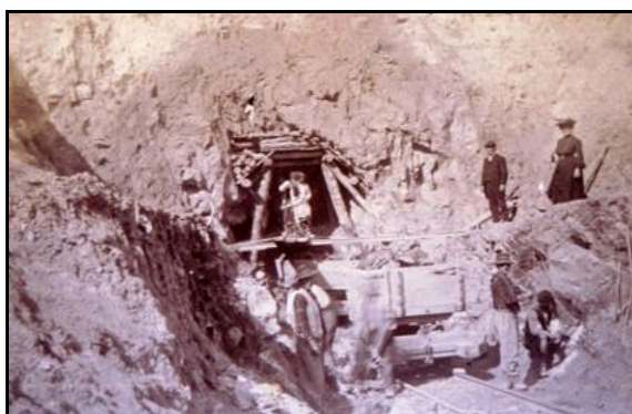
Ces deux photos montrent un stade plus avancé de la galerie de reconnaissance dont le radier a été abaissé On notera aussi le fait que les brouettes sont remplacées par un wagonnet sur rails
