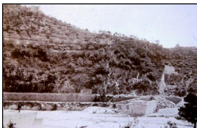
Début de construction de la culée Est du pont qui précède A l'arrière-plan, la fouille d'entrée du tunnel pas encore creusé
