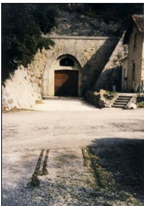
Ci-contre, l'entrée du tunnel dans son état actuel Les rails de l'ancien passage à niveau sont les seuls survivants de la ligne
