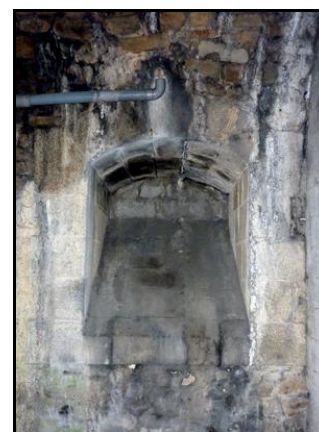
Meurtrières de défense situées dans l'entrée de la galerie en avant des portes de protection de l'ouvrage Elles sont aujourd'hui condamnées et murées La salle du corps de garde se trouve juste derrière
