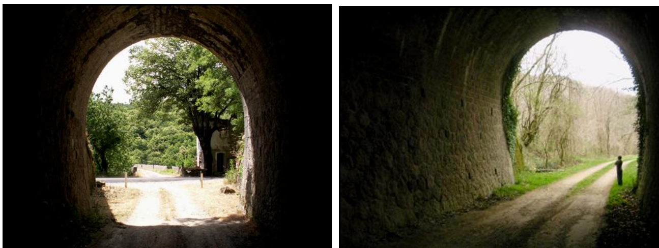
L'entrée et la sortie du tunnel vues depuis l'intérieur de la galerie
