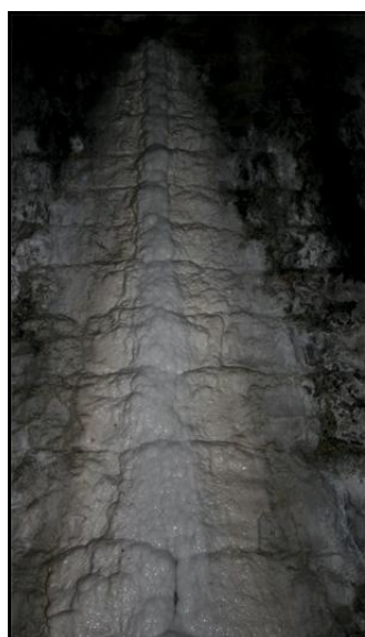
Ci-dessus et ci-dessous, coulées d'eau sur les parois du tunnel
