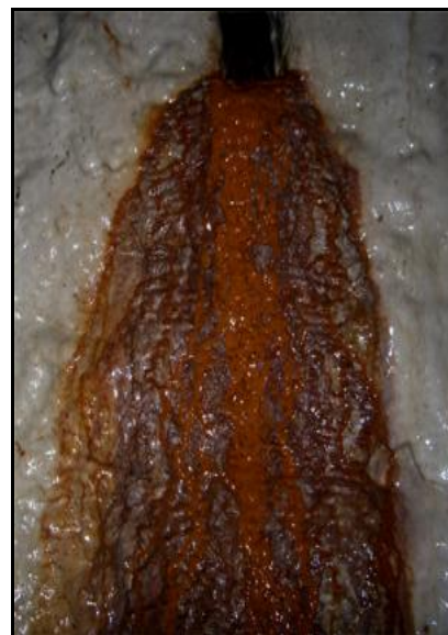
Ci-dessus et ci-dessous, coulées d'eau sur les parois du tunnel
