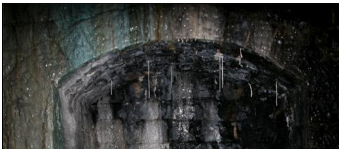
Ci-dessus et ci-dessous, coulées d'eau sur les parois du tunnel
