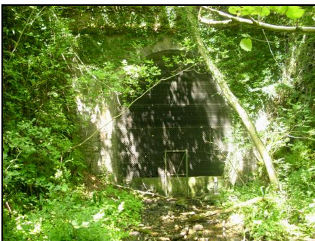
La sortie fermée par une grille
