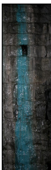
Ci-dessus et ci-dessous, coulées d'eau sur les parois du tunnel
