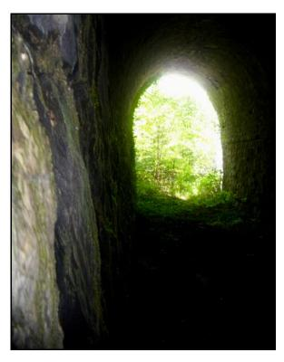
Photo de l'entrée prise à contre-jour, montrant bien l'ovalisation du tunnel et le bombé de la paroi droite imputables aux poussées du terrain
