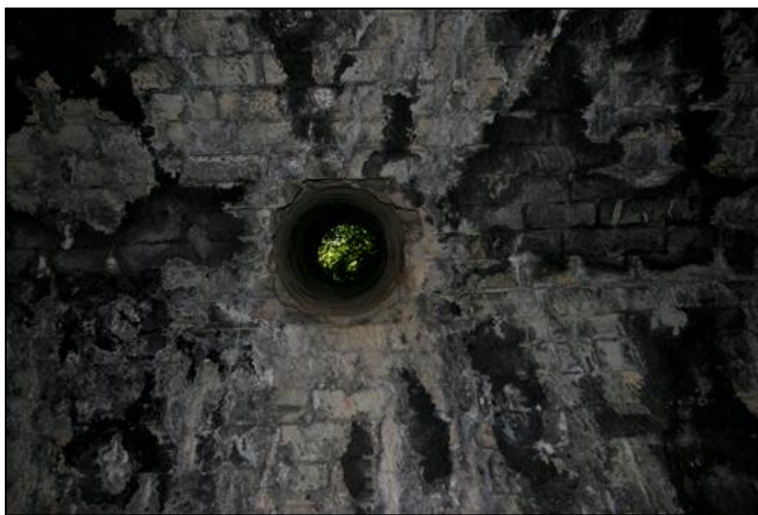
La cheminée axiale, dans la voûte
