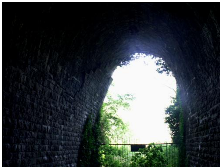
La section nettement ovalisée du tunnel, vue à contre-jour
