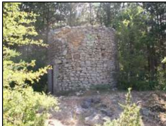
Le puits d'aération et sa tour de protection (dont le toit a aussi disparu)
