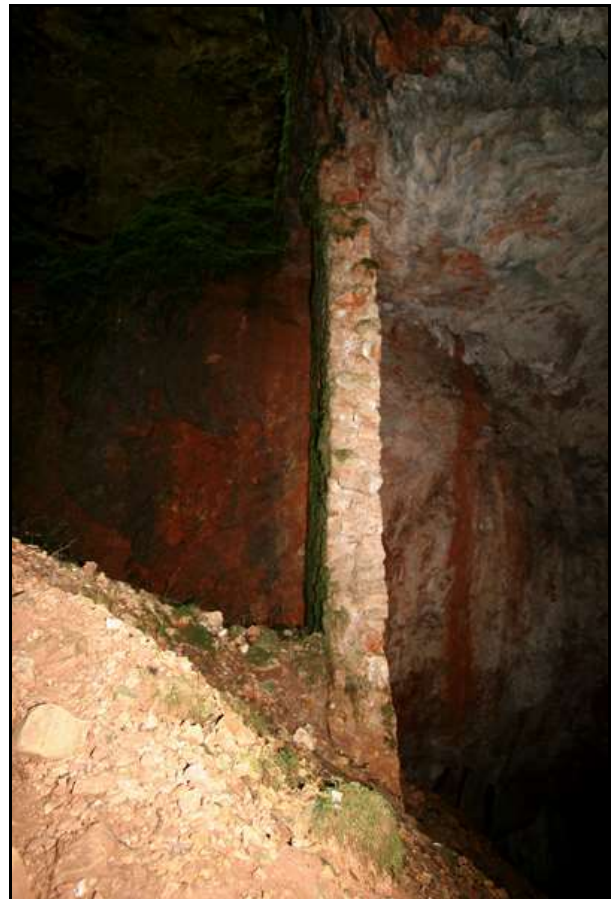
Ci-dessus et ci-dessous, le mur d'isolation vu de face et de côté
