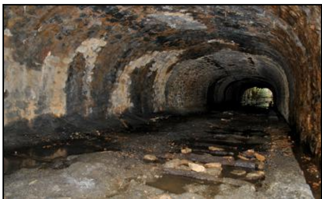
La galerie dans sa partie large à deux voies avec, au plafond, les traces résiduelles de suie des locomotives à vapeur
