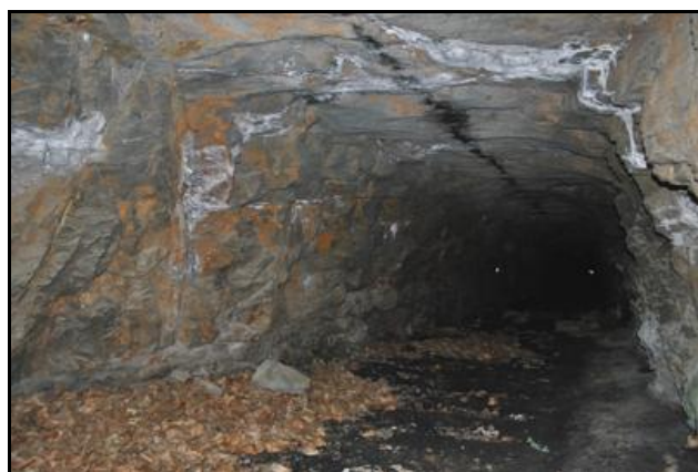
La partie de galerie à voie unique, taillée dans la roche vive avec quelques chutes de blocs
