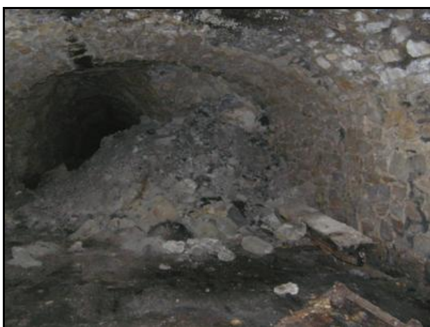
L'effondrement principal juste à l'endroit où la galerie se rétrécit et cesse d'être maçonnée
