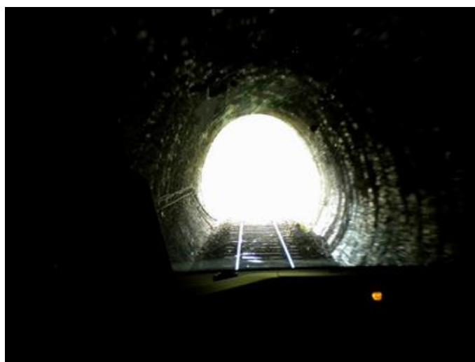
La sortie vue depuis une cabine de conduite
