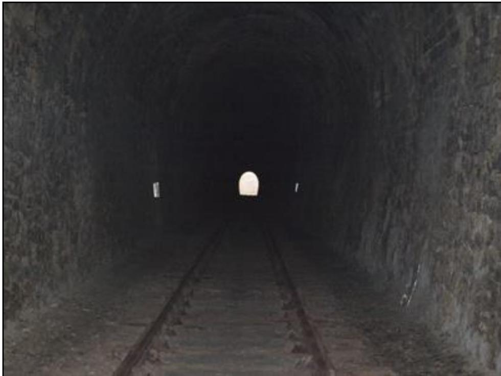
Les deux taches blanches de part et d'autre de l'entrée sont des plaques réflectrices qui signalent des niches abris.
