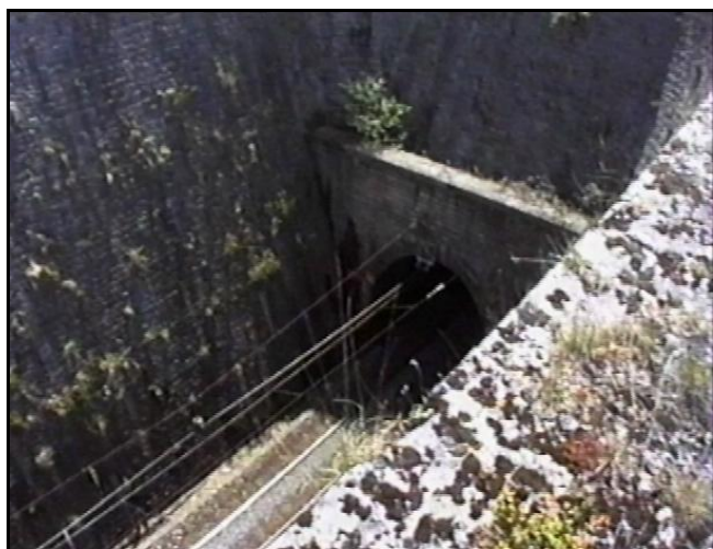
L'entrée dans sa profonde tranchée d'accès
