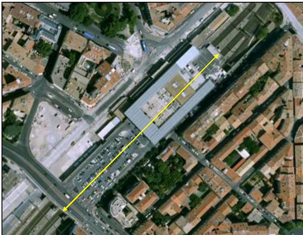
Vue aérienne de la galerie souterraine de la gare Saint Roch
