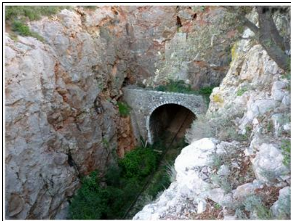
Vue plongeante sr la sortie du tunnel
