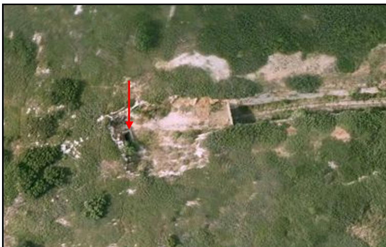
Côté entrée, au bout de la courte section en tranchée couverte, l'orifice du puits de jour, bien visible
