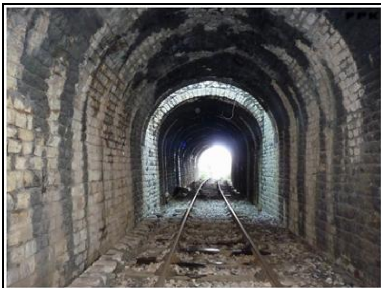
Depuis l'intérieur, vue sur le puits de jour et l'entrée du tunnel
