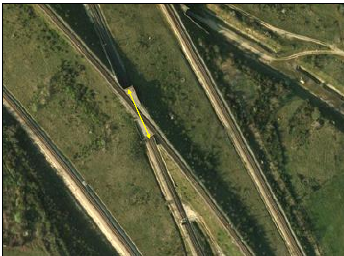
Vue aérienne du saut de mouton des Briches LGV
