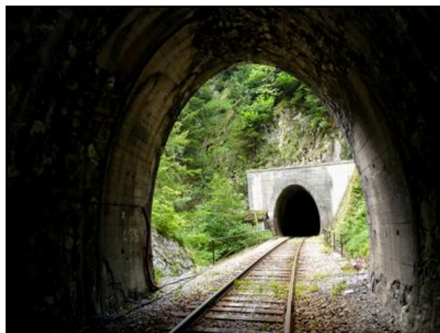
La sortie du tunnel de Bois Noir vue depuis l'intérieur de la galerie Et l'entrée du tunnel de la Croix Haute
