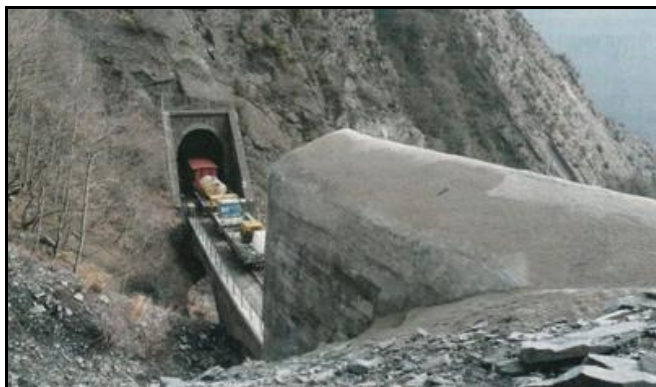
L'arrière et le toit de la galerie de protection avec l'entrée du tunnel des Brondes
