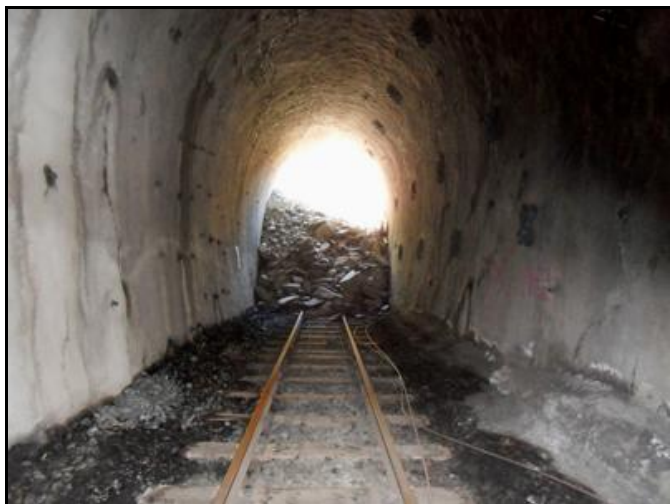
La sortie obstruée par l'éboulement
