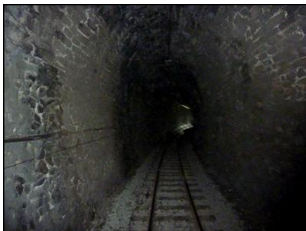
Ci-contre et ci-dessous, la galerie du tunnel
