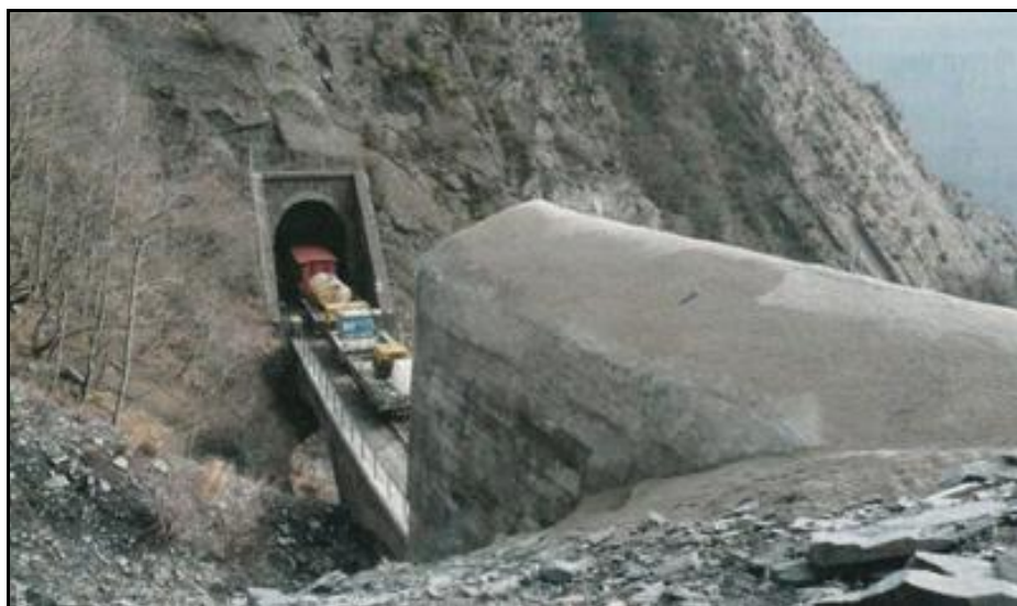
Au premier plan, la galerie de protection qui prolongeait la sortie du tunnel de Serguignou et qui a été emportée par l'éboulement le 26 octobre 2010
