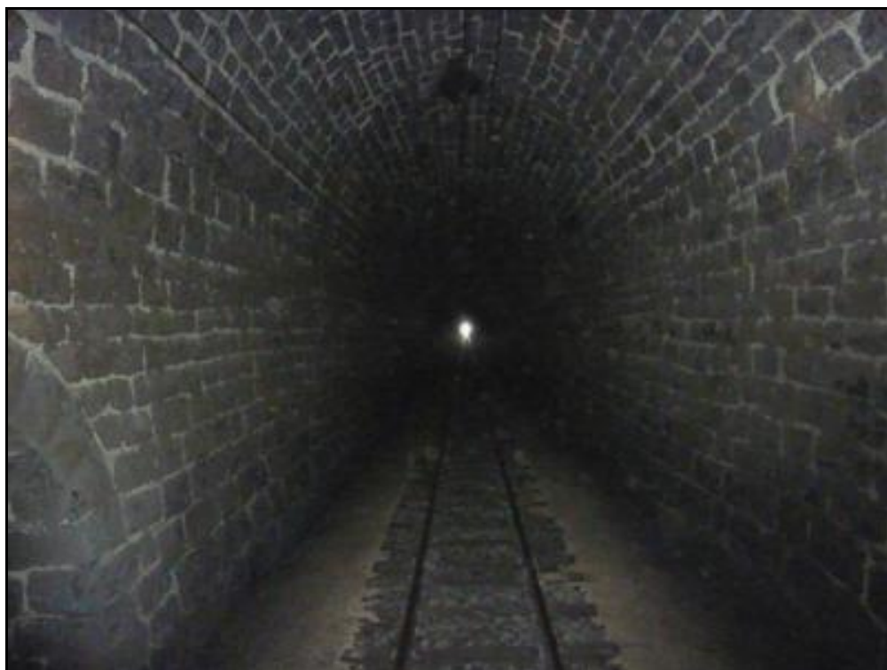
L'entrée du tunnel Notez les déflecteurs installés sous la voûte pour détourner les infiltrations
