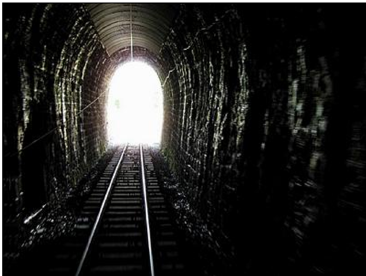
L'entrée du tunnel Notez les déflecteurs installés sous la voûte pour détourner les infiltrations
