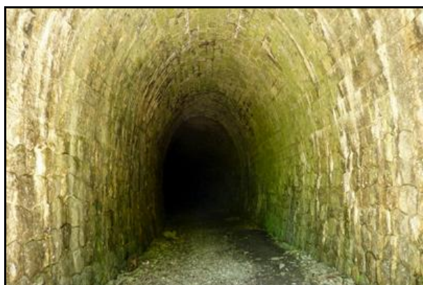
Divers aspects de la galerie en roche vive avec des anneaux maçonnés de renfort par endroits
