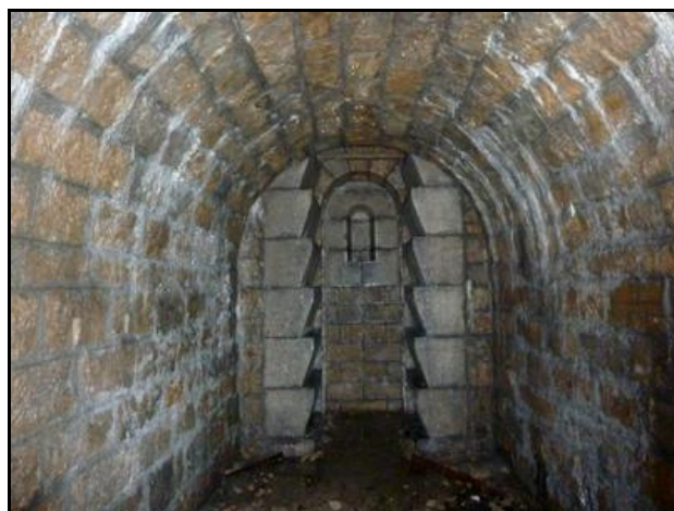
Accès et antichambre vers la cheminée verticale des fourneaux de mine
