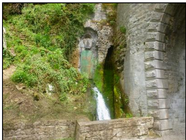
Détail du captage de la source située à gauche de l'entrée
