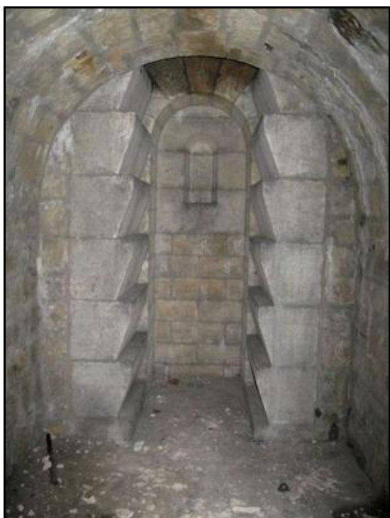
Détail des marches en opposition qui permettent de grimper le puits Et vue de celui-ci depuis le bas
