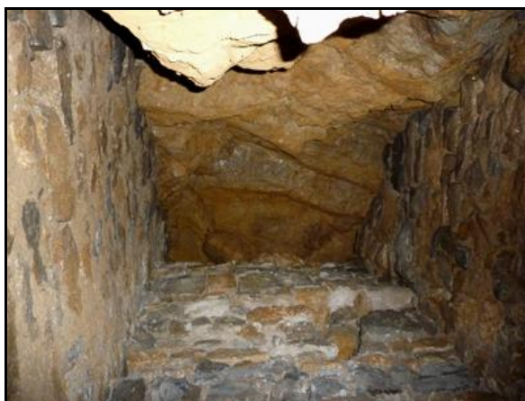
Photo verticale montrant deux contreforts de maintien du piédroit (au bas de la photo) et la possibilité de grimper sur l'extrados de la voûte dont on perçoit l'arrondi externe
