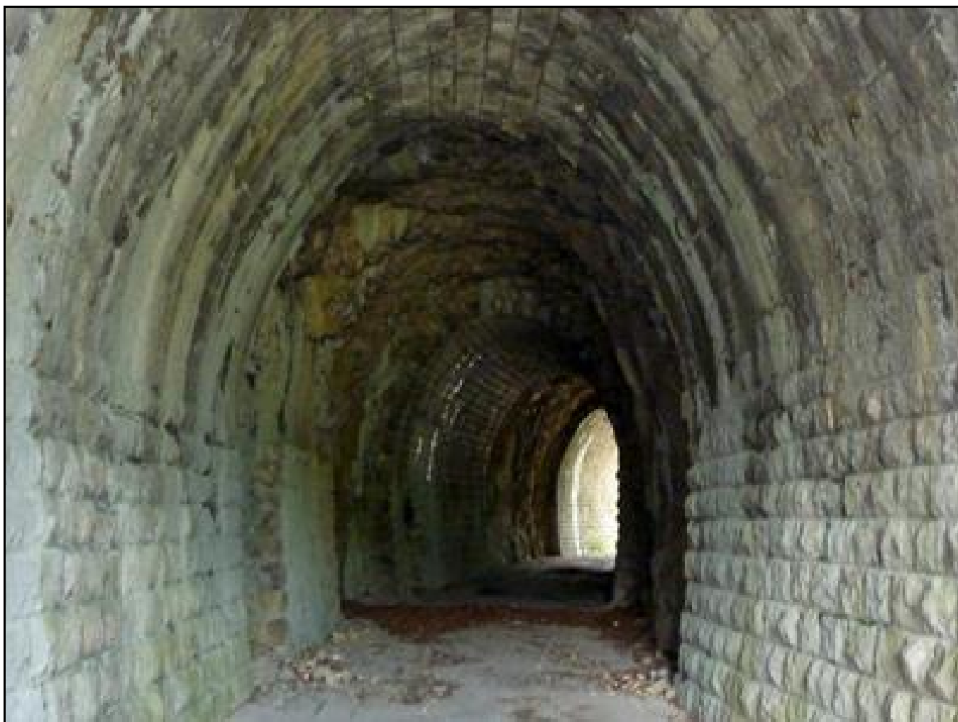
La galerie en partie en roche vive et en partie maçonnée
