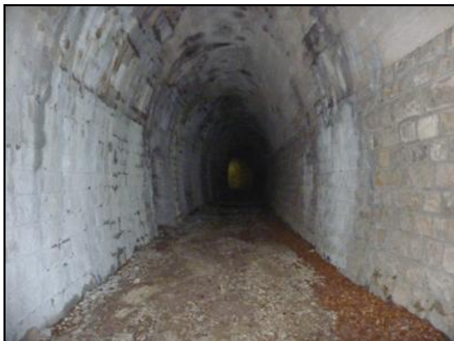
La forme en S du tunnel
