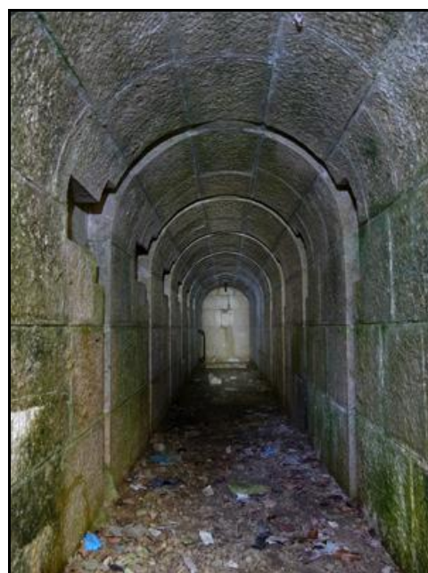
Galerie latérale avec puits vertical au fond
