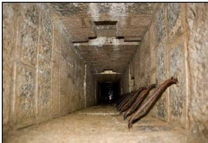
Puits d'accès à l'un des fourneaux latéraux
