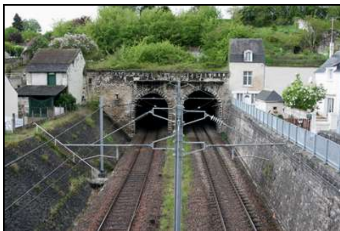
Le tunnel Montrichard Nord 2 est ici à droite
