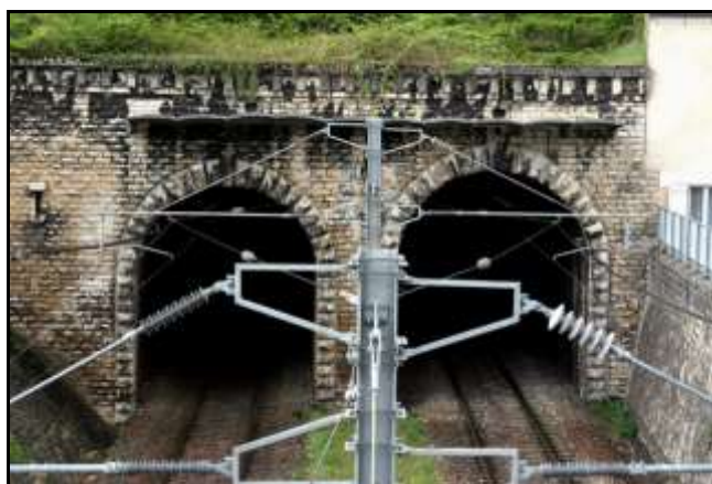
Deux photos entrée / sortie montrant très clairement l'asymétrie des galeries et la différence de hauteur entre la galerie ancienne (plus basse) et la galerie nouvelle (plus haute)
