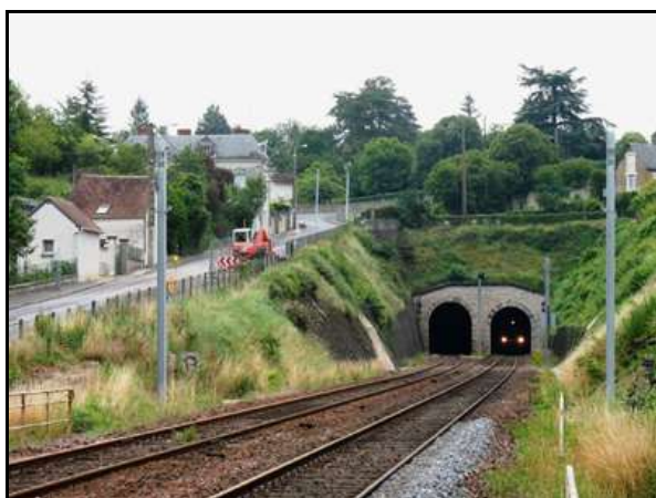
Le tunnel Montrichard Nord 2 est ici à gauche
