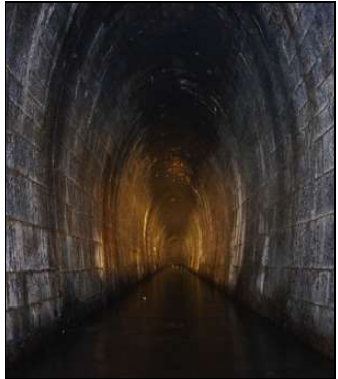
D'importantes infiltrations, des fistuleuses de 6 m de long qui tombent de la voûte, et le lac donnent un aspect de grotte naturelle au tunnel Sur la photo de droite, au fond, l'effondrement qui ferme la galerie à 300 m de l'entrée
