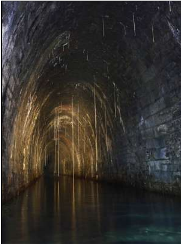
D'importantes infiltrations, des fistuleuses de 6 m de long qui tombent de la voûte, et le lac donnent un aspect de grotte naturelle au tunnel Sur la photo de droite, au fond, l'effondrement qui ferme la galerie à 300 m de l'entrée
