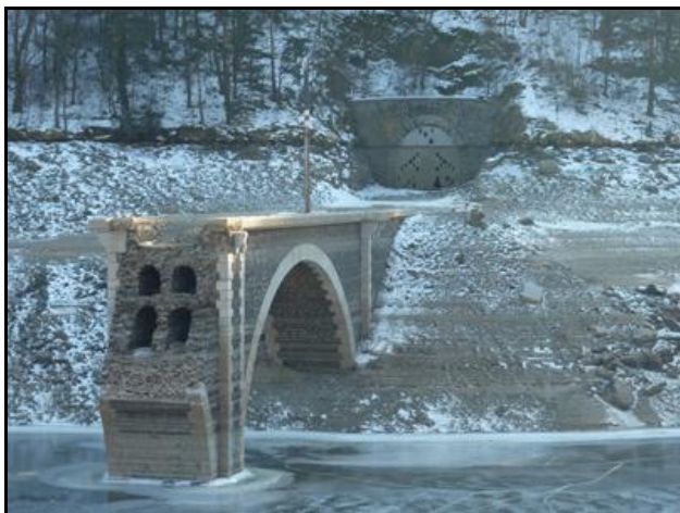
Au premier plan, un ancien viaduc détruit
