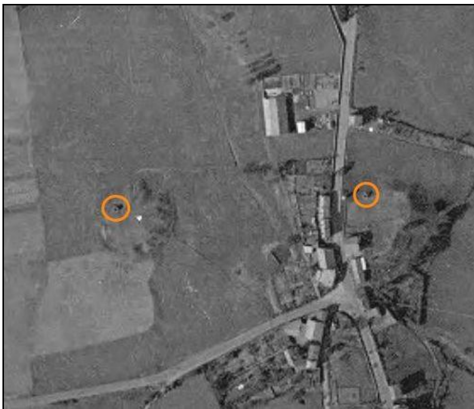
Position des deux cheminées d'aération bien visibles dans le paysage
