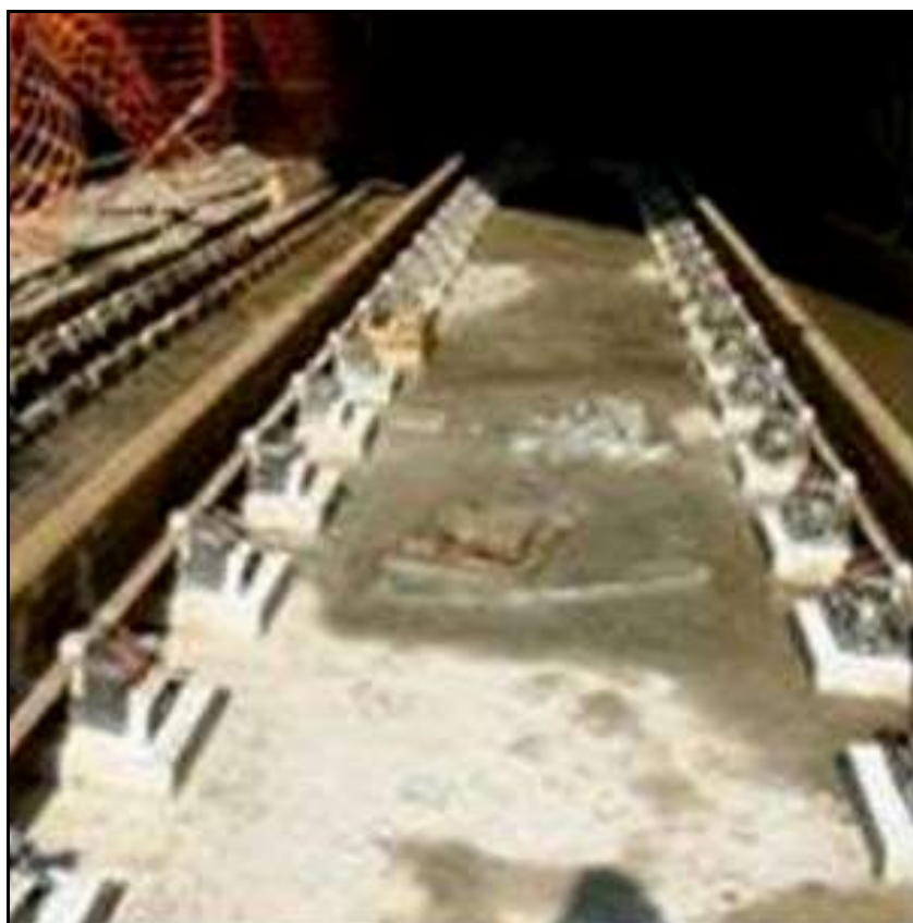
Ci-dessus et ci-dessous, coulage de la dalle et pose de la voie
