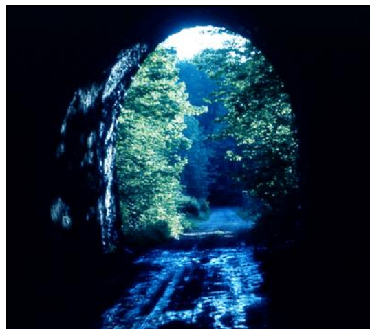
La sortie vue de l'intérieur
