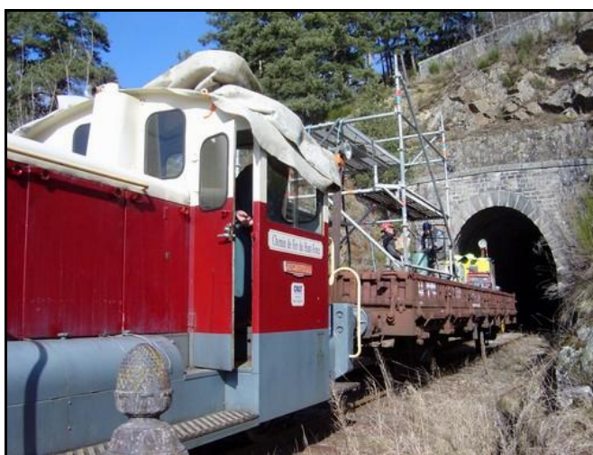
Train de travaux devant la sortie
