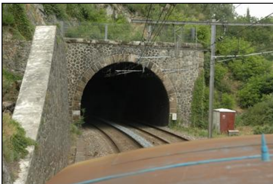
Une dernière vue sur la sortie prise depuis une locomotive
