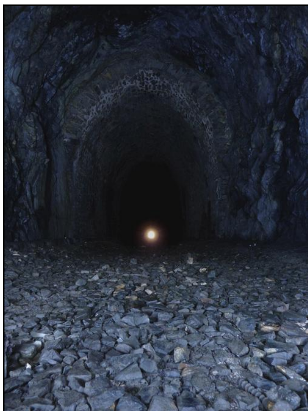
Ci-dessus et ci-dessous, trois photos de la belle galerie du tunnel dont certaines parties ne sont pas maçonnées, mais dont la radier est parfois inondé
