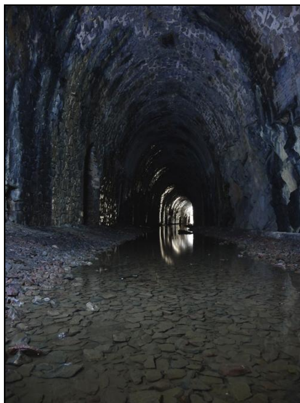
Ci-dessus et ci-dessous, trois photos de la belle galerie du tunnel dont certaines parties ne sont pas maçonnées, mais dont la radier est parfois inondé
