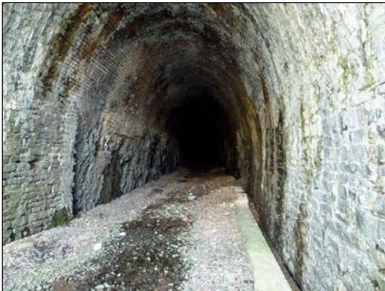
Ci-dessus et ci-dessous, trois photos de la belle galerie du tunnel dont certaines parties ne sont pas maçonnées, mais dont la radier est parfois inondé
