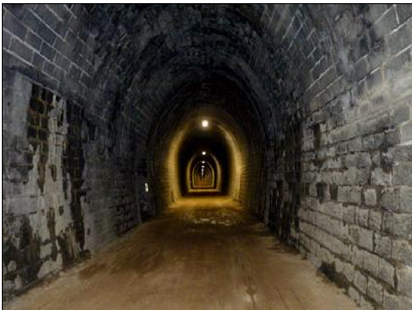
La partie centrale du tunnel et sa longue ligne droite
